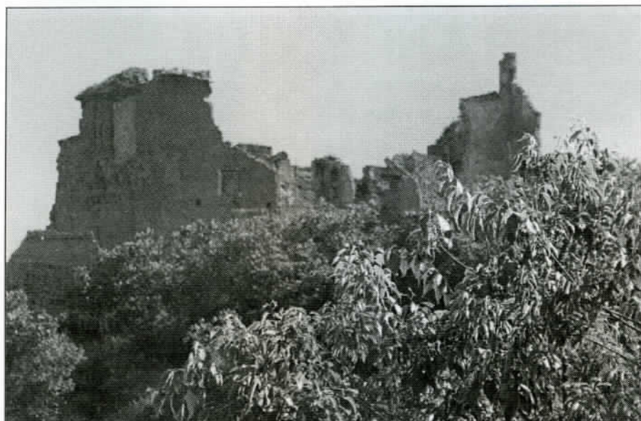
Lo poco que queda del castillo del Lugar Alto
